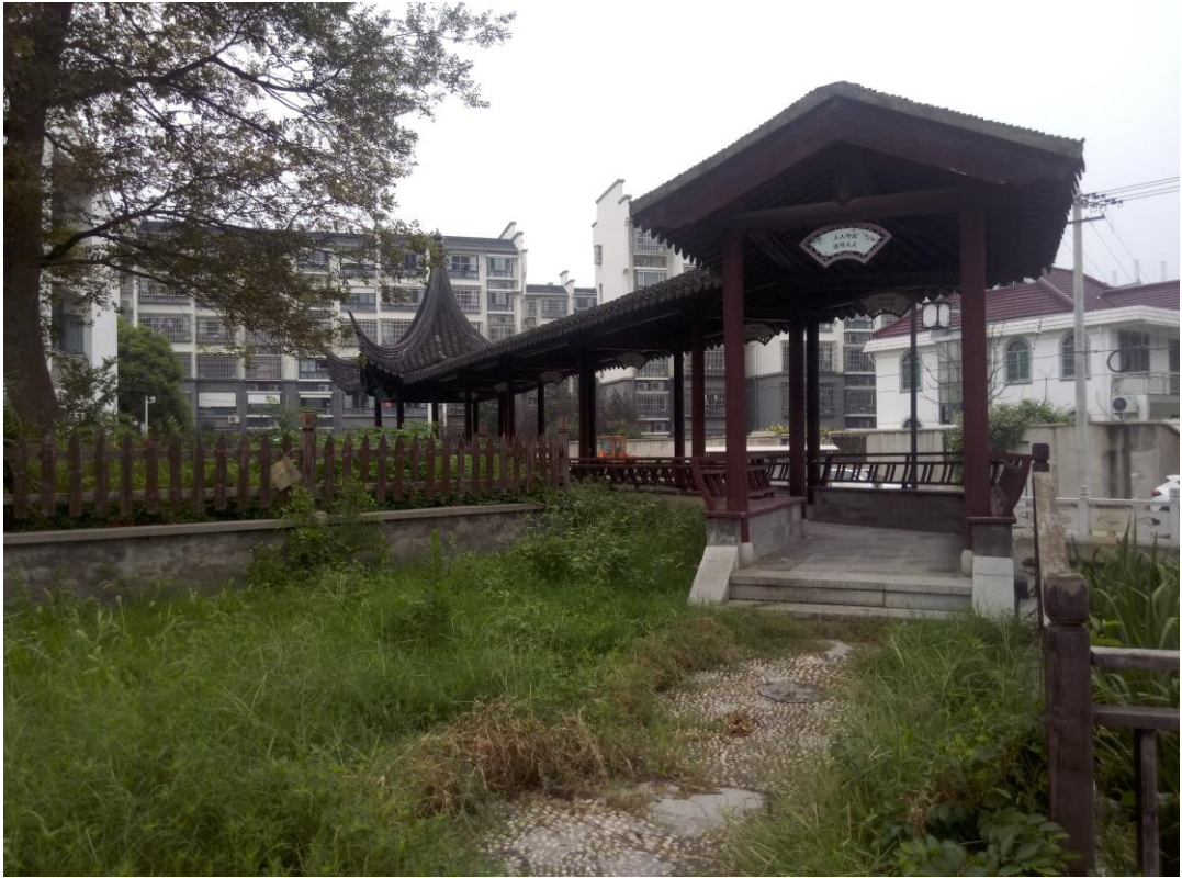
圖（四）甬直古鎮基地勘查
